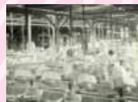
1934年頃の小倉工場の様子。都市の近代化や下水道の整備によって衛生陶器の需要が拡大していった
