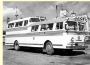
セミダブルデッカーバス 昭和29年11月に導入された日本初のセミダブルデッカー車。 1958(昭和33)年頃 所蔵:西日本鉄道(株)
